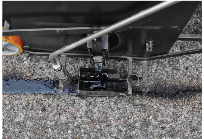
Fylling av spriker med varm bitumen
