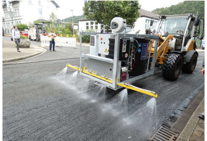
Sprøyting med hydratkalk
