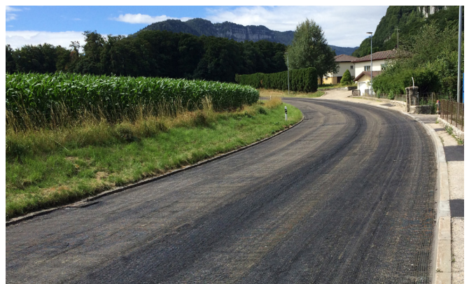
Eksempel på et S&P asfaltarmeringsnett installert i en kurve
