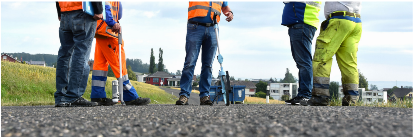
S&P teknikere gir støtte og råd på byggeplassen
